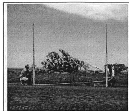
Na locação do talude de montante e crista da lombada, a cota do pé do talude de montante deverá ser transferida para a estaca posicionada na crista da lombada e posteriormente acrescida entre 10 cm e 30 cm e demarcada com talisca para orientar a altura que a crista da lombada será construída.
